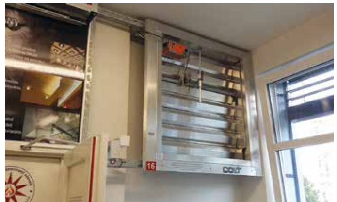
Dveře s přídržným magnetem, kouřová zástěna, klapka zařízení pro odvod kouře a tepla
