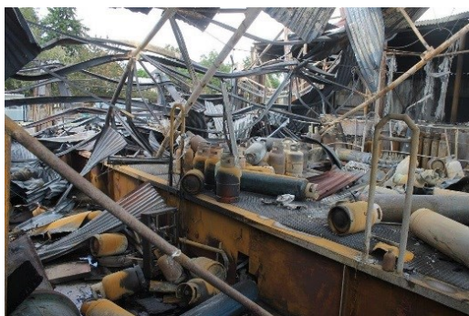
Obrázek 5 Zničená budova skladu tlakových lahví po požáru a následných explozích lahví [9]
