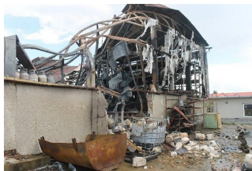
Obrázek 5 Zničená budova skladu tlakových lahví po požáru a následných explozích lahví [9]
