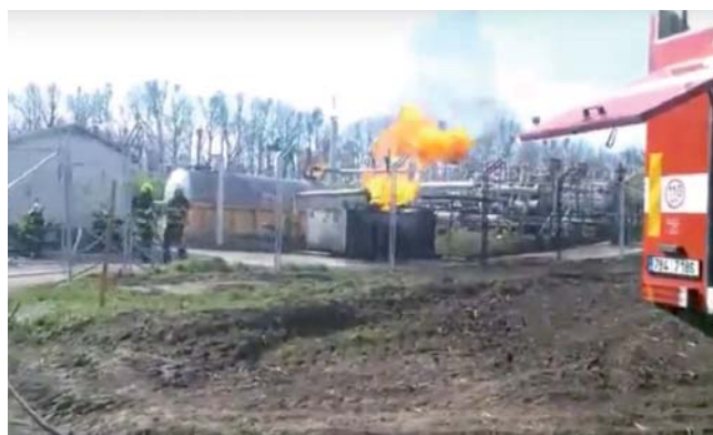
Obr. 1 Situace po příjezdu prvních jednotek
