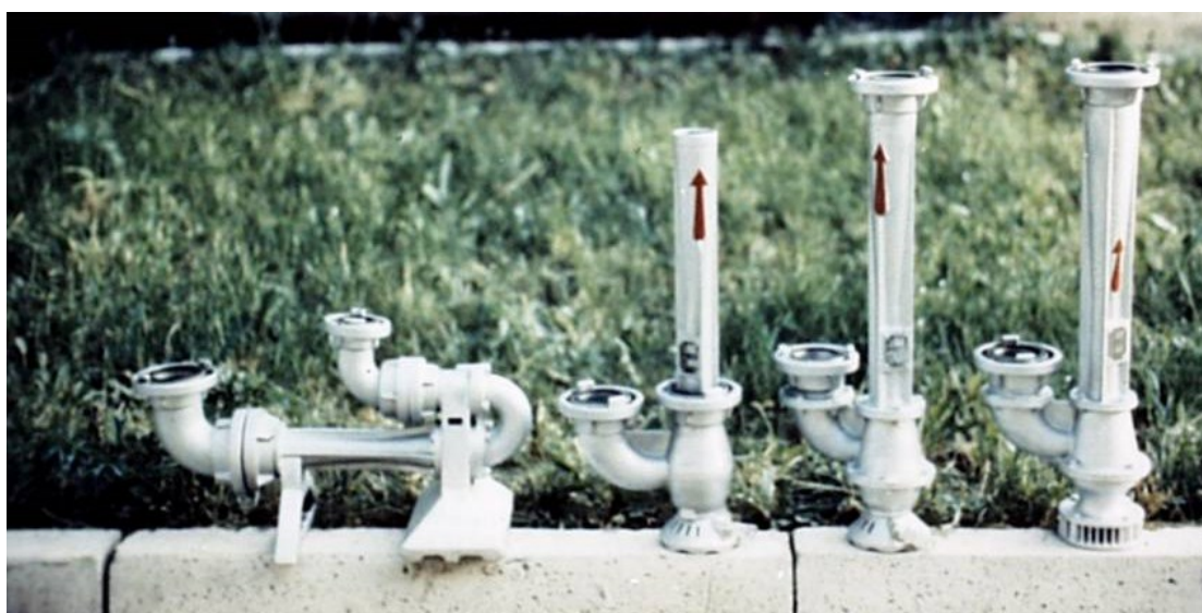
Obr. 2.5 Ležatý a stojaté ejektory [2.3]
