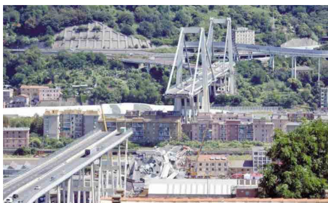
Obr. 1 Havárie Trojské lávky [9] (nahore) a havárie mostu Ponte Morandi, Janov, Itálie [1] (dole)
