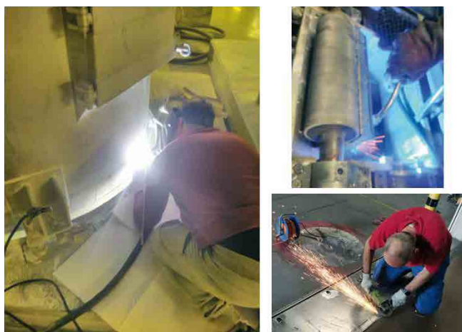
Obr. 4 Svařečské a řezačské práce prováděné na pracovišti [autor]
