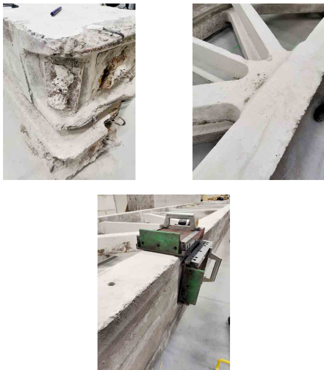
Obr. 4 Betonové bloky nosníků s plochými ocelovými lany včetně umístěného defektoskopu
