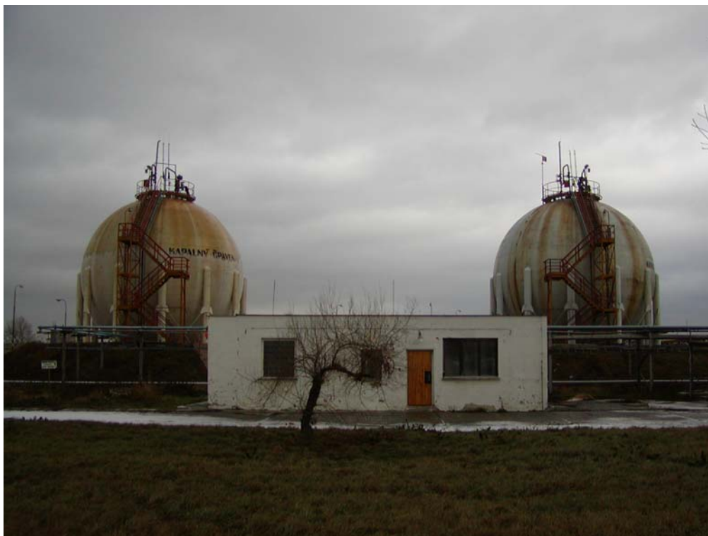
Foto č.1: Celkový pohled na sklad amoniaku
