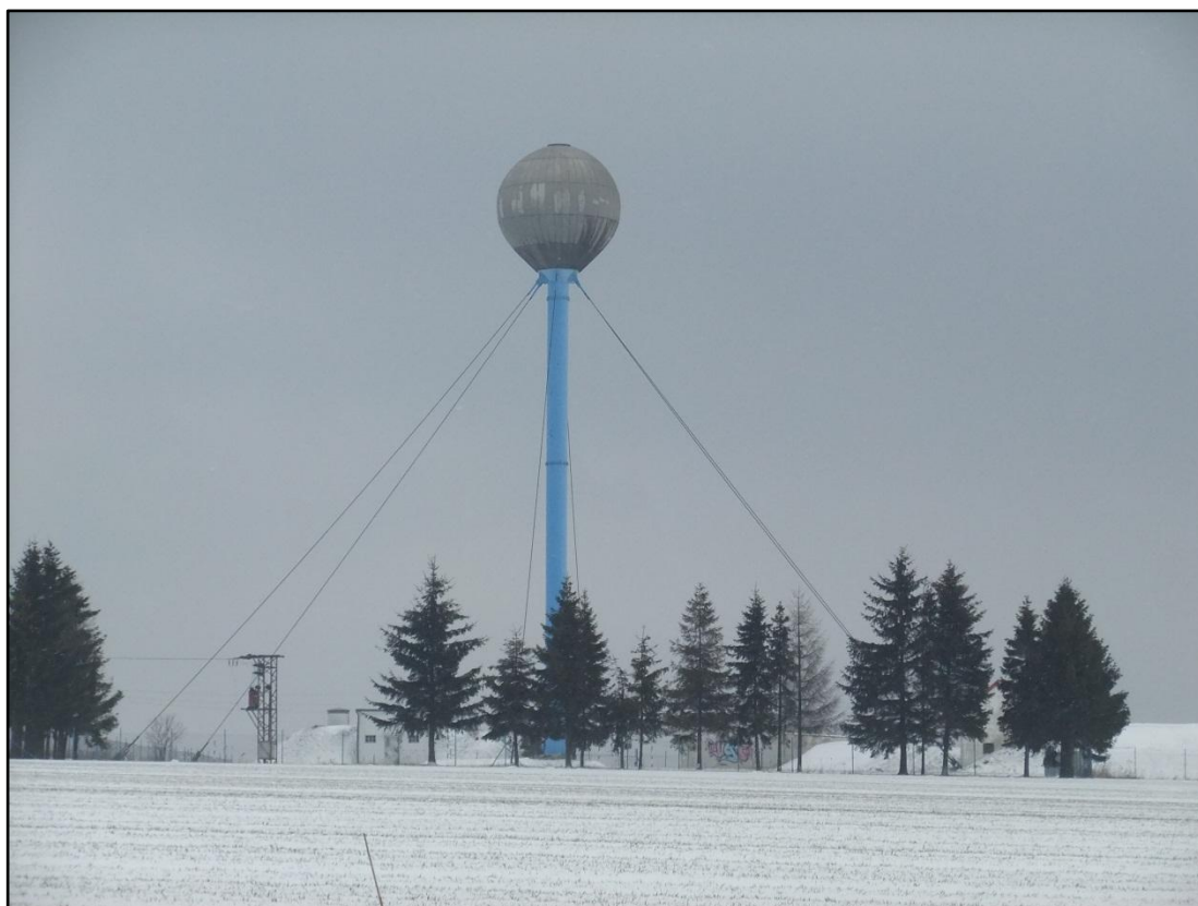
Obr. 7.14 Vodojem typu hydroglobus na vnitřním vodovodu
