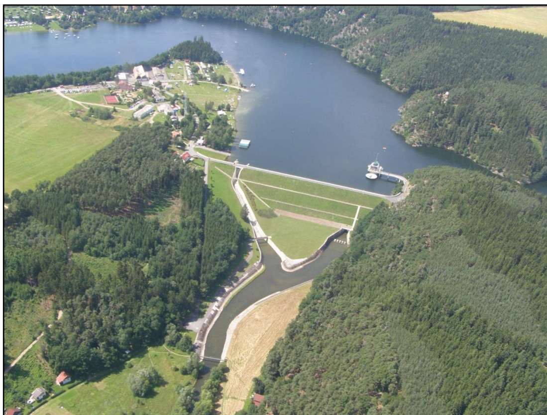
Obr. 4.1 Vodárenská nádrž s jímacím objektem skupinového vodovodu
