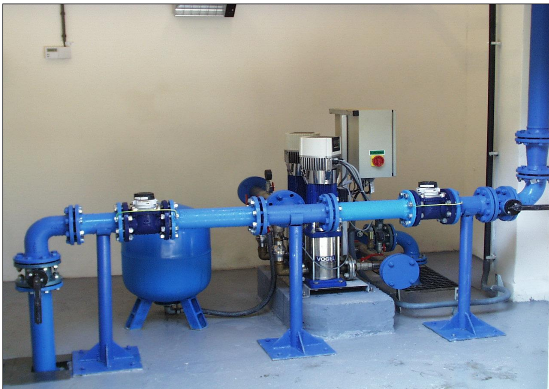
Obr. 7.15 Automatická tlaková stanice vhodná pro vnitřní vodovody
