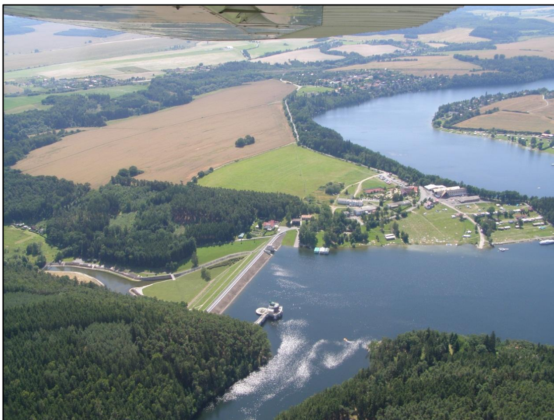
Obr. 1.10 Vodárenská nádrž s jímacím objektem skupinového vodovodu
