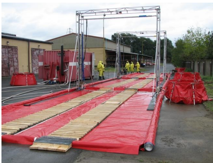
Obrázek 4.17 Stanoviště dekontaminace techniky SDT 09 [8]
